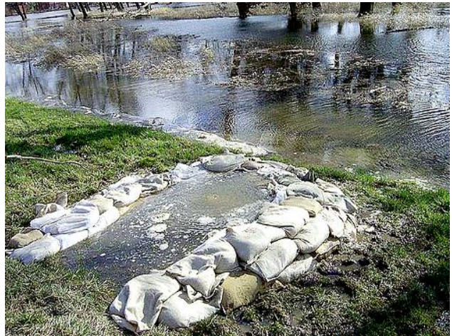
Foto 15: noch starker Wasseraustritt
