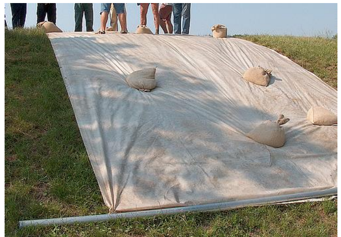
Foto 4: Folie nach dem Ausrollen
