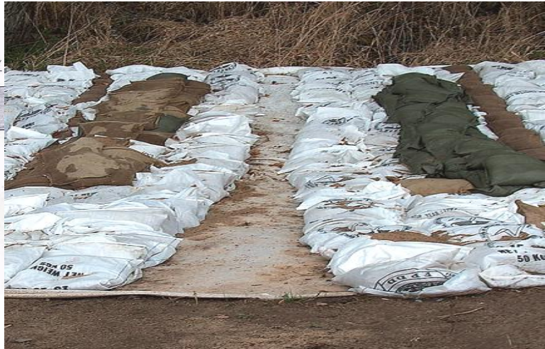
Foto 26: Auflast mit Vlies und Sandsäcken
