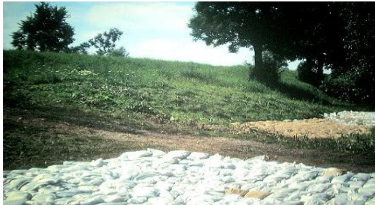
Foto 27: Auflast mit Kies in Sandsäcken
