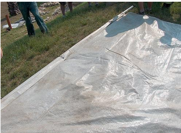
Foto 3: Vorbereitung der Folie
