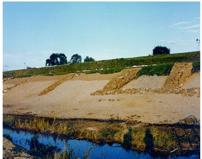
Foto 35: massive landseitige Sicherung
