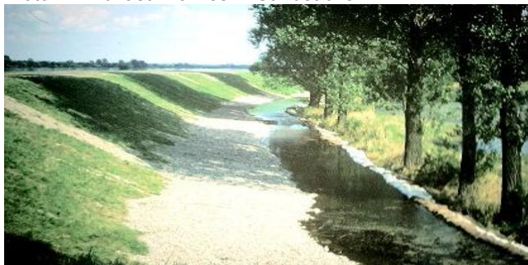
Foto 28: Auflast mit losen Kies
