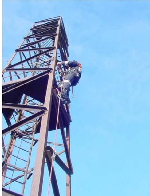
Ausrüstung: PSA mit Zubehör; 1 Dynamikseil (Bergseil EN 892); diverse Bandschlingen und geeignete Karabiner mit Verschlussicherung für Zwischensicherungen; für HMS Dreiwegeverschluss-Karabiner verwenden
