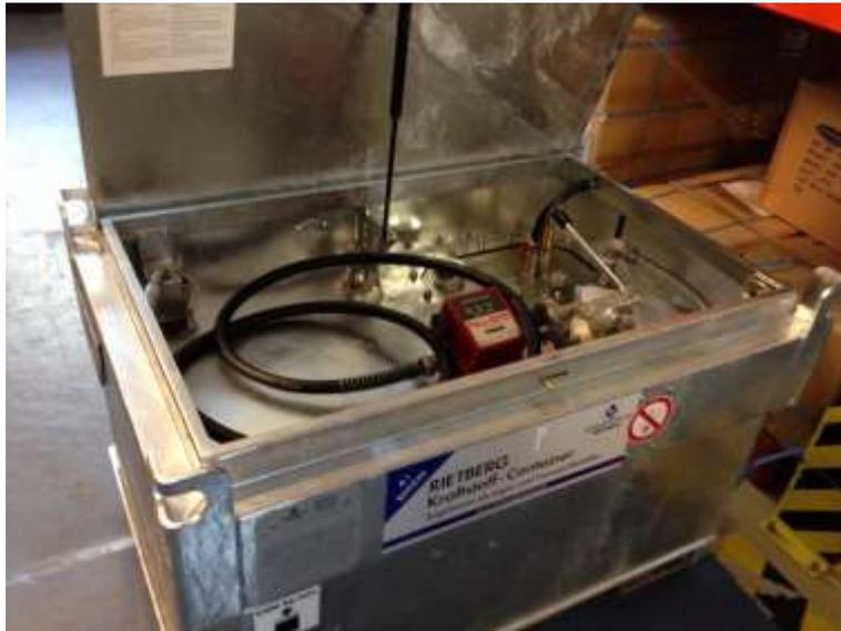
In der FF Unterwellenborn-Könitz steht ebenfalls eine mobile Tankanlage. Diese hat jedoch ein Fassungsvermögen von 450 l Dieselkraftstoff (Bild).
